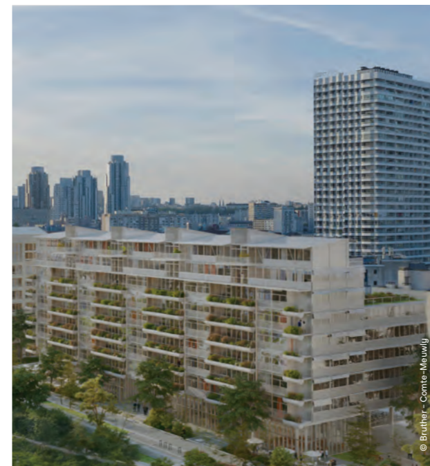
D Paris Habitat: Bruther + Comte / Meuwly → 7 779 M 2 de logements (98 logements dont 72 sociaux et 26 intermédiaires) → 774 m 2 d'activités / commerces Façade: mur rideau bois-aluminium + fermacel
