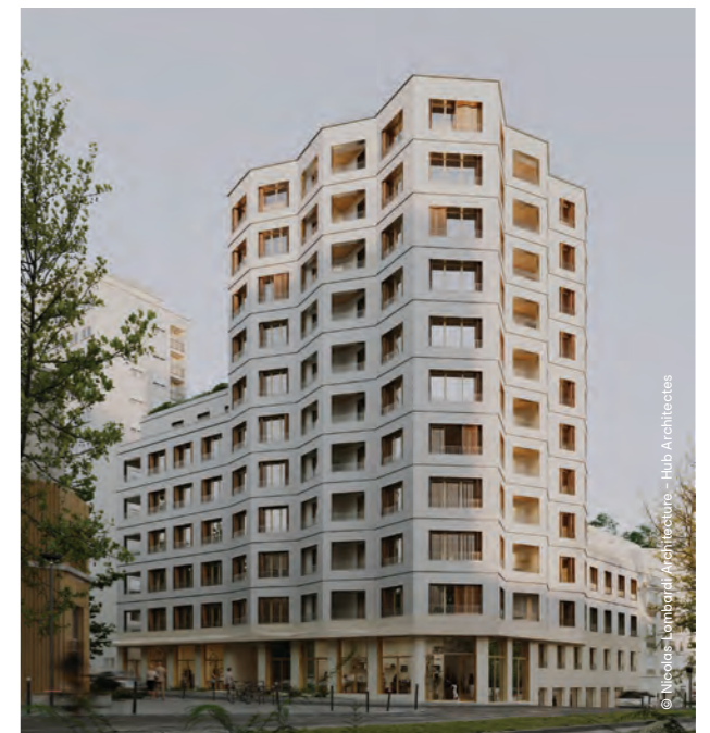
F Élogie-Siemp pour La Foncière de la Ville de Paris: Nicolas Lombardi Architecture + Hub → 3 231 m 2 de logements BRS (41 logements) → 191 m 2 d'activités / commerces Façade: façade ossature bois (FOB) paille hachée + enduit
