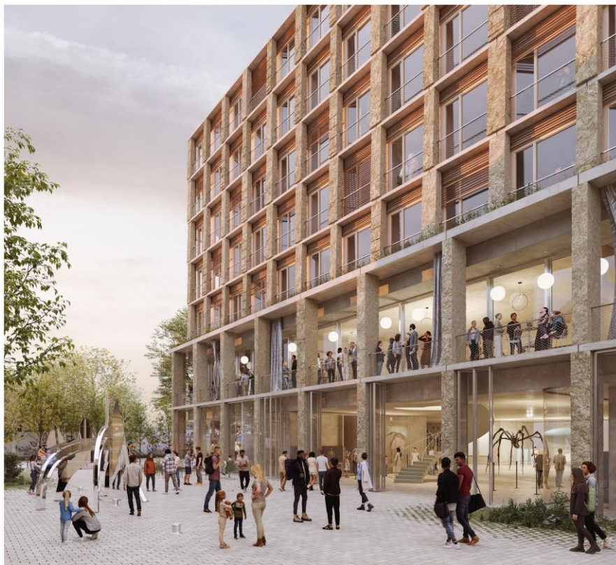
Bâtiment Denfert depuis la voie d'accès au site Saint-Vincent-de-Paul ©Armand Nouvet
