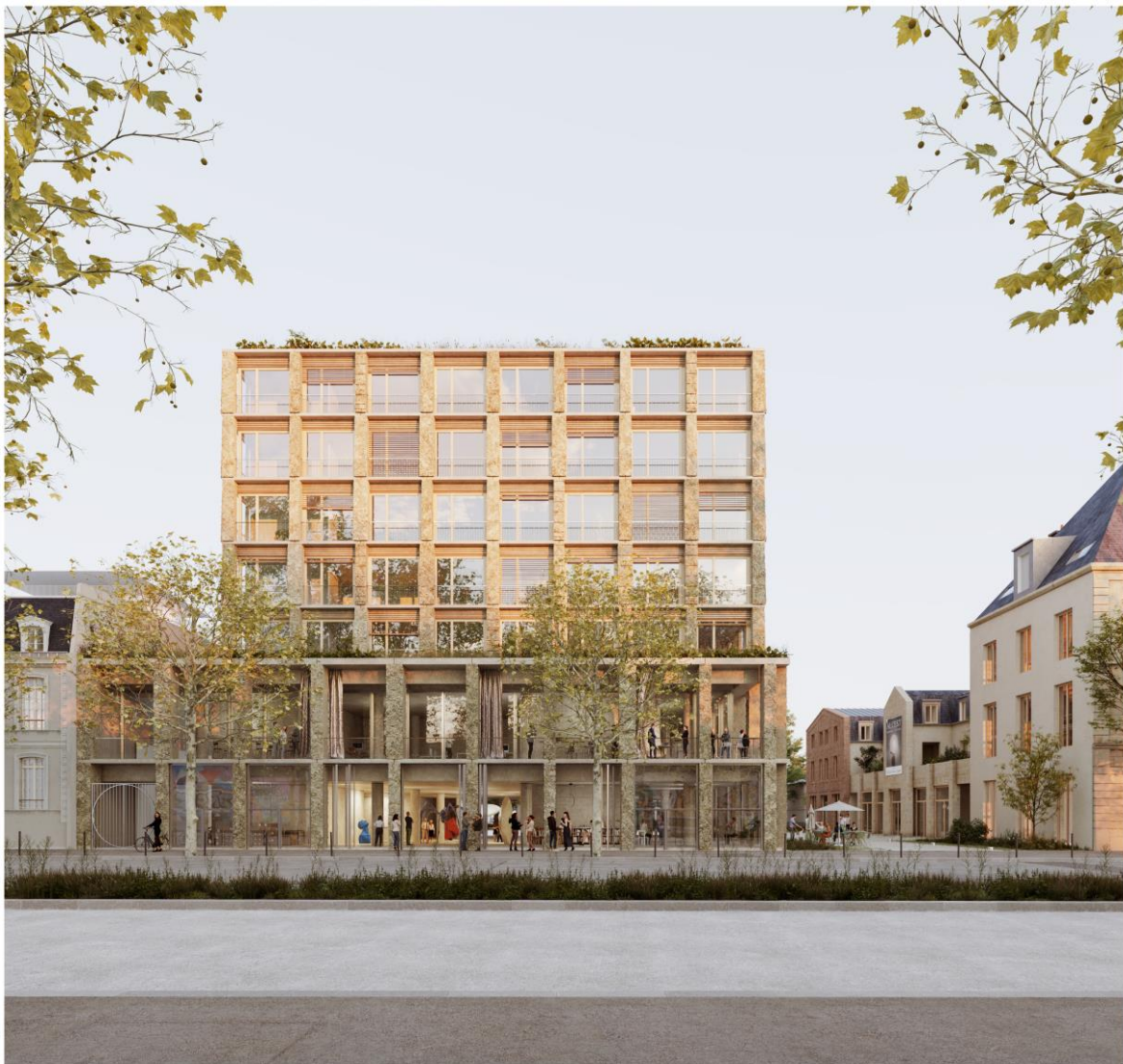
Bâtiment Denfert depuis l'avenue Denfert-Rochereau ©Armand Nouvet
